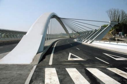
Figura 23. Arriostramiento transversal del arco.
