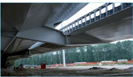
Figura 17. Unión de rampa de acceso con el tronco del viaducto. Puente de Padua
