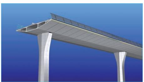
Figura 43. Detalle de las pilas. Primer subtramo del Tramo Viaducto de acceso a Puerto Rreal. Puente sobre la Bahía de Cádiz
