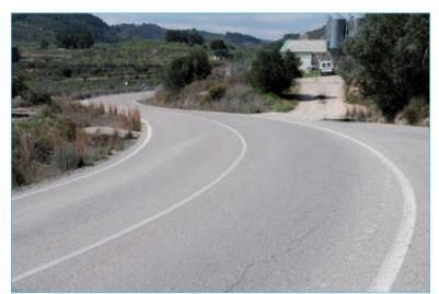
Foto 3. Alineación horizontal curvilínea continua.
